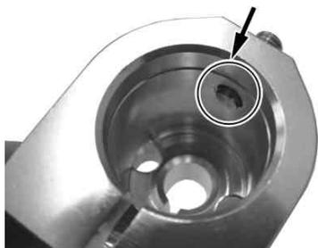
6. ハンドルポスト2をピンとステムシャフトの溝の位置を合わせて取り付けます。ハンドルポストピンを軽くねじ込んだ後、六角ナット6mmを使用してピンをロックします。ソケットキャップスクリュー10×35を取り付け、指定トルクで締め付けます。
